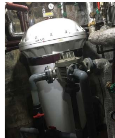
実際の循環ろ過機
